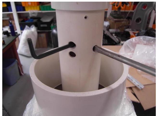
Usando una llave grande (o bloqueo de canal), deshaga los dos accesorios roscados de PVC (foto derecha) y retire la brida de la paleta.
