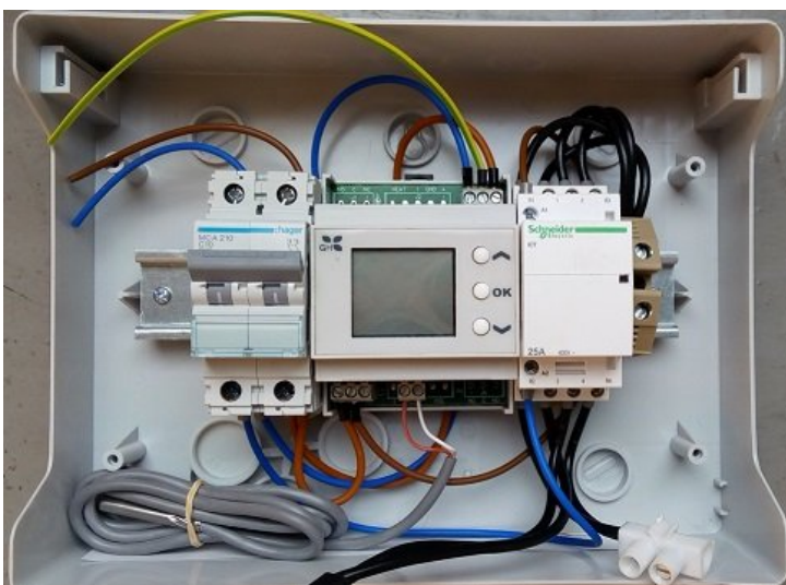
Cuadro eléctrico lado Vac con termostato con salida relé
